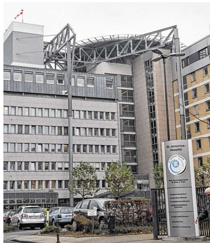
Markantes Bauteil in 38 Metern Höhe: die neue Helikopter-Plattform über dem St.-Antonius-Hospital.
