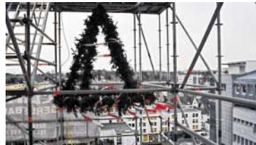
► Ein halbes Stockwerk hoch ist der Richtkranz, der seit gestern am achten Stock hoch über der City vor der Fassade des Hospitals hängt.
