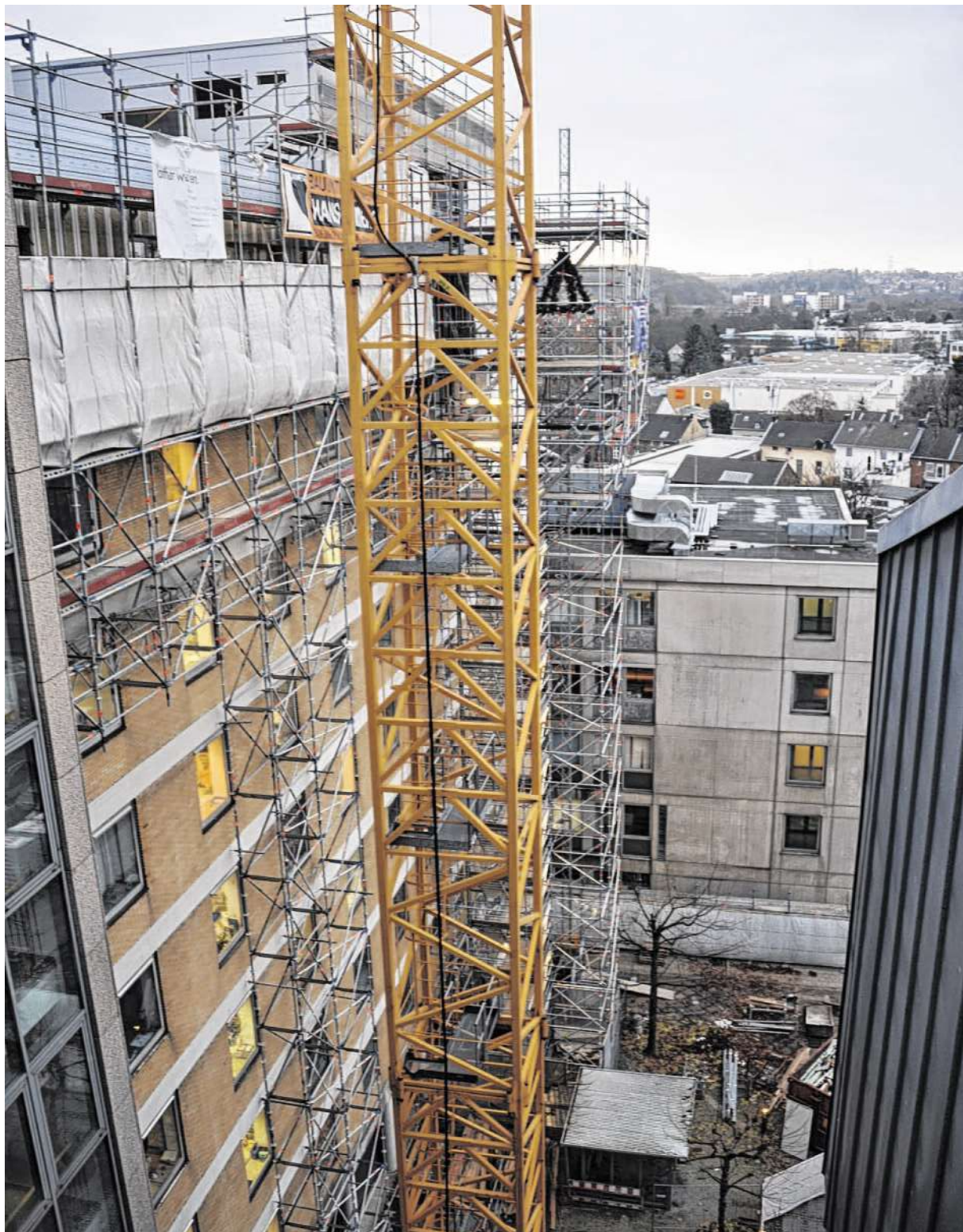
Noch stehen Kran und Baugerüst vor der Fassade des Hospitals. Im Herbst kommenden Jahres soll die fast neun Millionen Euro teure Großbaustelle Vergangenheit sein. Foto: Rudolf Müller
