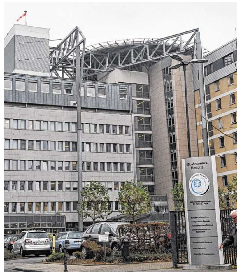
Markantes Bauteil in 38 Metern Höhe: die neue Helikopter-Plattform über dem St.-Antonius-Hospital.
