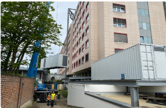
Anlieferung und Aufbau von zwei Notstromaggregaten.
