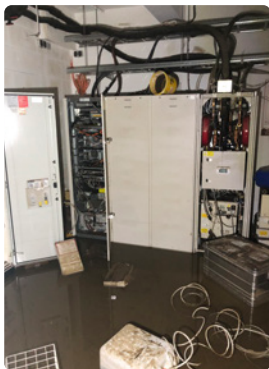
Die Spannungsversorgung im Untergeschoss – ebenfalls ein Opfer der Wassermassen.
