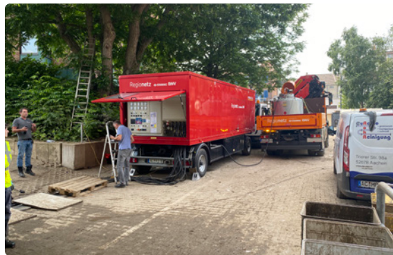
Ein externes Stromaggregat übernahm zunächst die Versorgung des Hauses.
