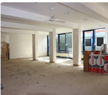
Entkernung des ursprünglichen ERZ-Gebäudes.
