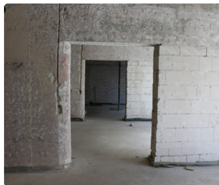
Entkernung der ursprünglichen Räume im Untergeschoss.
