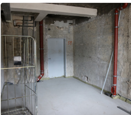
Entkernung im ehemaligen Bereich Untergeschoss.
