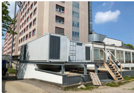
Anlieferung und Aufbau von zwei Notstromaggregaten.
