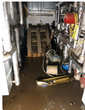
Die Spannungsversorgung im Untergeschoss – ebenfalls ein Opfer der Wassermassen.
